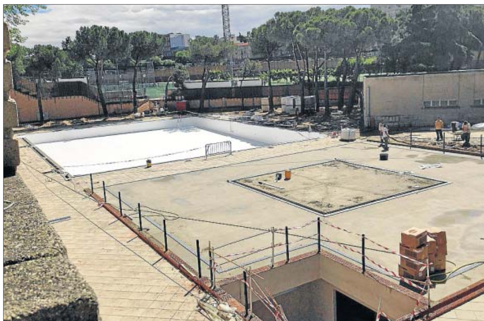
Piscina del Barrio de la Concepción, todavía en obras.
