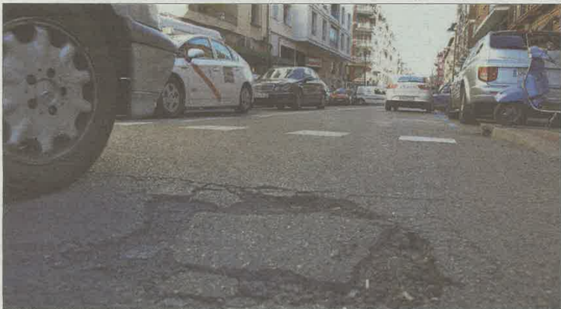
Un bache en una calle del distrito de Salamanca. SERGIO GONZÁLEZ VALERO
