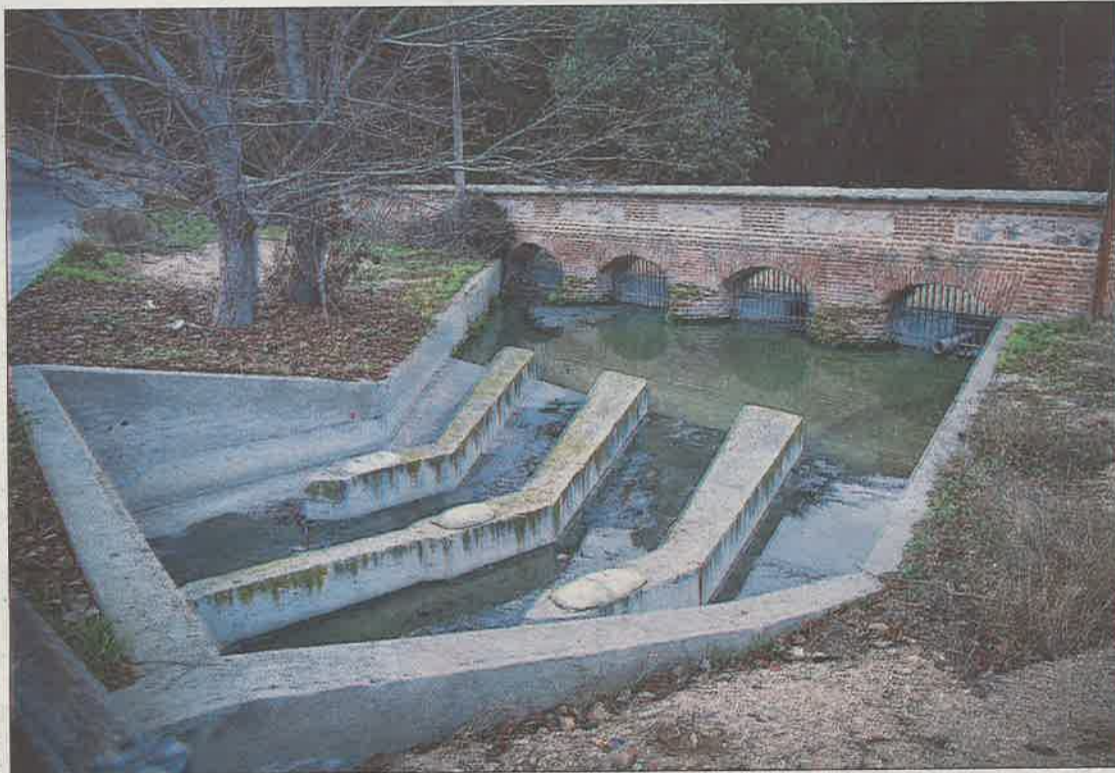
La reja rehabilitada del arroyo Meaques, obra de Francesco Sabatini (siglo XVIII), en la cerca histórica que delimitaba el parque, permite la entrada del agua e impide al tiempo la salida de los animales. / SANTI BURGOS
