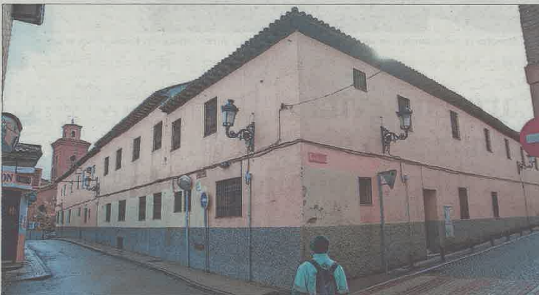
Edificio situado junto a la iglesia de Hortaleza que conservará su fachada. / SANTI BURGOS
