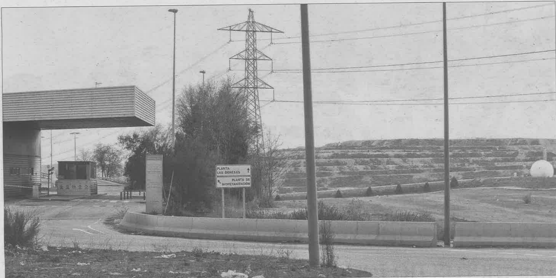
Entrada a la planta de Valdemingómez. A la derecha se encuentra la zona donde se realizan labores de compostaje que podrían causar los malos olores. BERNARDO DÍAZ
