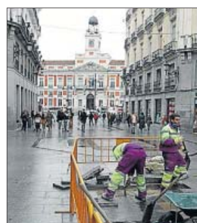
MADRID AVISA. Botella ha ampliado la cobertura del servicio Madrid Avisa y exige a la adjudicataria que arregle los baches con mayor rapidez. En la foto, operarios en Preciados.
