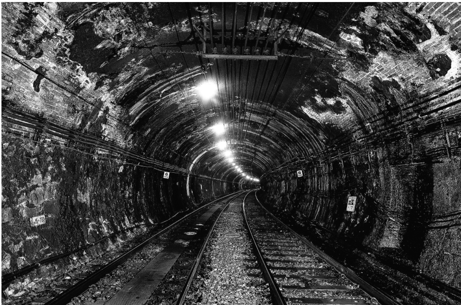
Un tramo del túnel de la línea 1 de Metro que será reformado a partir de mayo. COMUNIDAD DE MADRID
