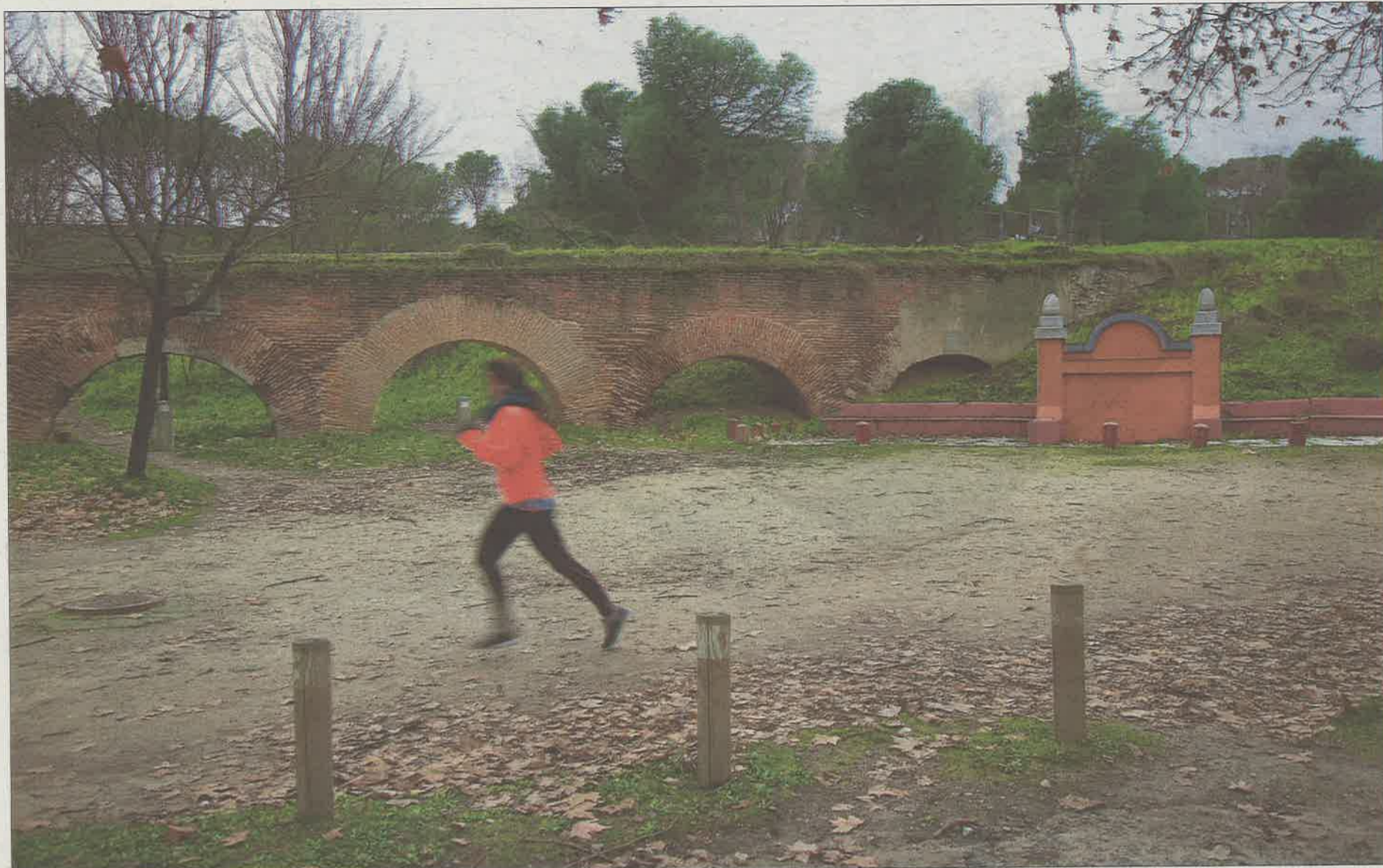
Acueducto de la huerta de La Partida, que trasladaba el agua del arroyo Meaques, con dos de sus arcos semienterrados y una fuente de la Segunda República delante. / SANTI BURGOS
