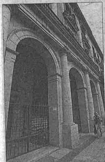
Edificio municipal en desuso en la calle de Alberto Agullera de Madrid. / S. SÁNCHEZ
