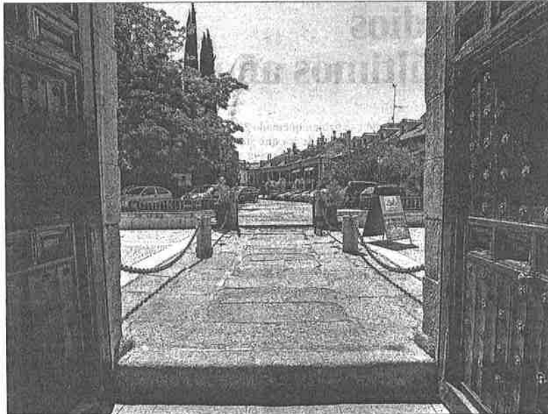
Entrada a la casa palacio Manuel de Godoy, en Villaviciosa de Odón. / KIKE PARA
