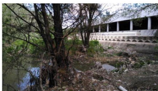
Vista del Aliviadero General de Margen Izquierda
