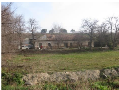
Casa del Peón, antes de las obras de rehabilitación
