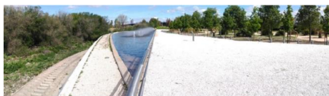
Vista de la parte superior del Aliviadero General de Margen Izquierda (AGMI)
