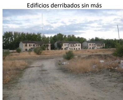
Edificios derribados sin más
