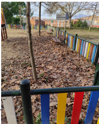
Puente de Vallecas. ED1. Suciedad
