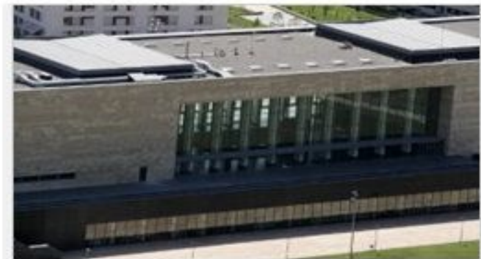
Las antenas de telefonía móvil se han instalado, sin licencia, en el tejado de Riojaforum. / S. ESPINOSA
