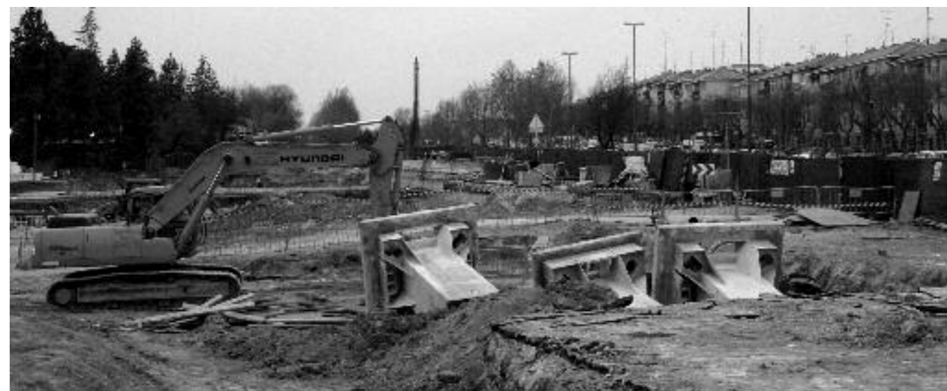
Imagen de las obras del intercambiador.
