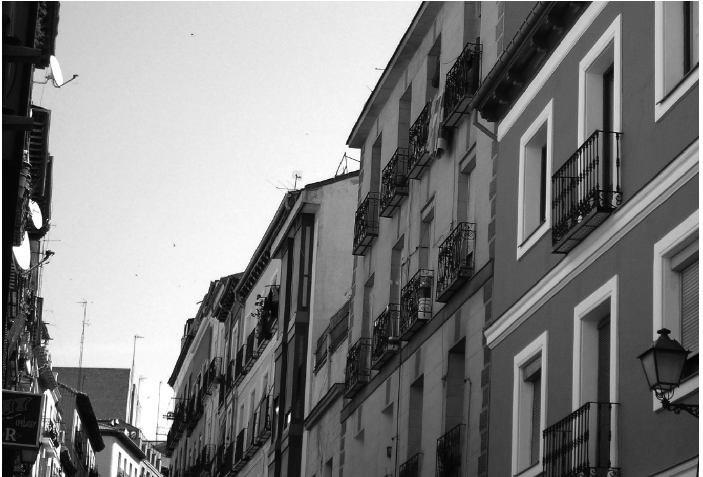
Viviendas rehabilitadas en Lavapiés
