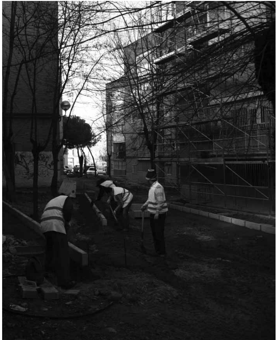
Edificio en rehabilitación en el distrito de Puente de Vallecas.
