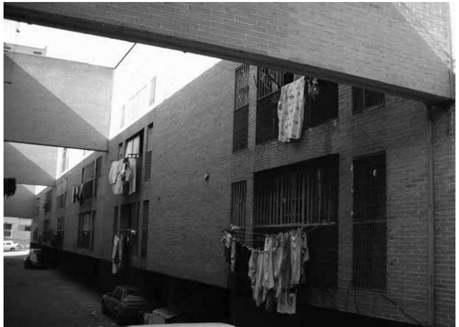
Un objetivo a corto plazo, la adecuación funcional de edificios en lo relativo a las ayudas para la instalación de ascensores.
