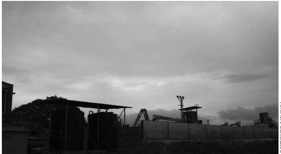
Imagen del depósito de residuos tóxicos de San Fernando
