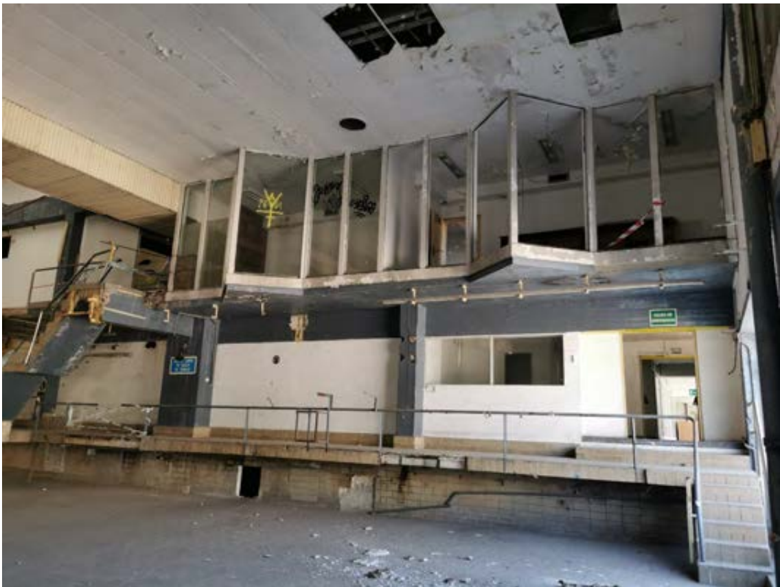
Figura A26. Estado actual de miradores. Autor 2023/04/04
