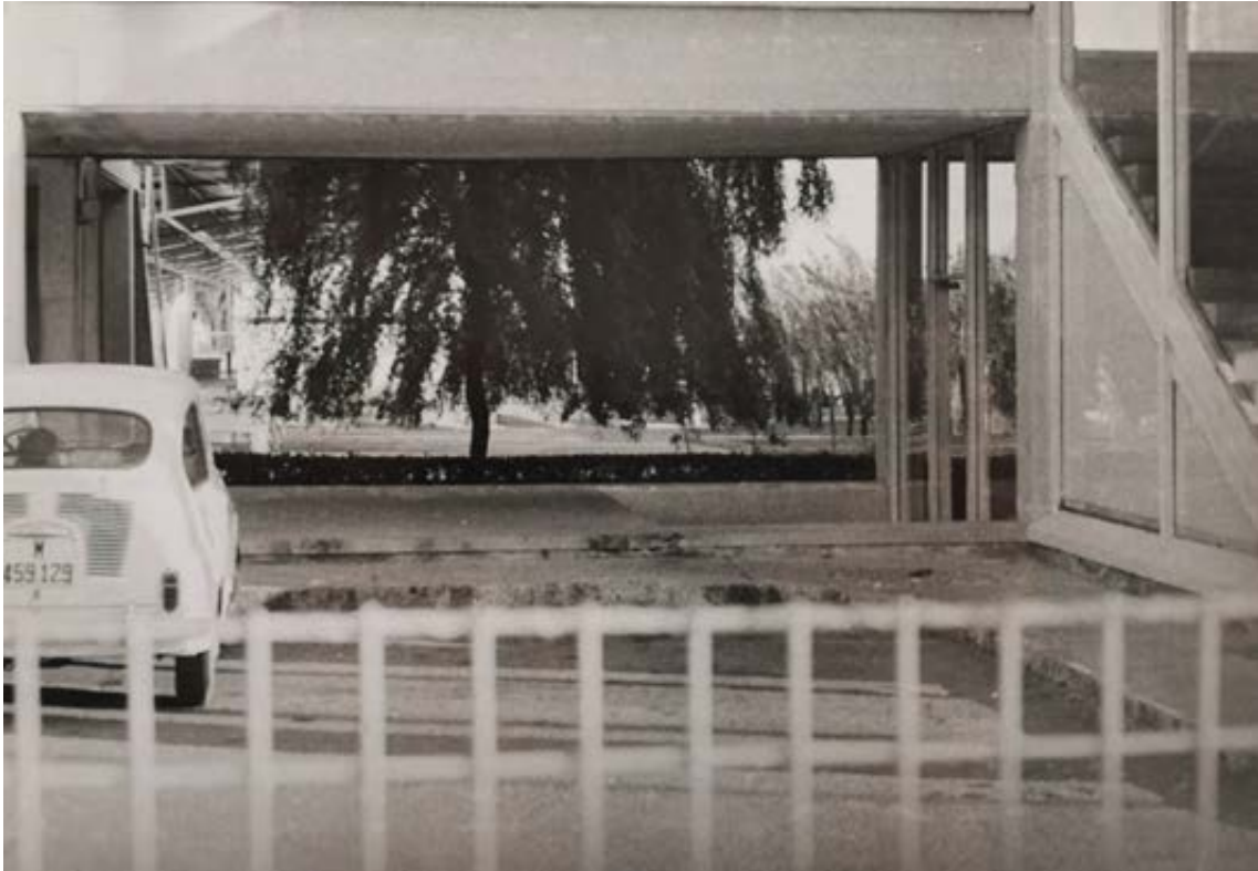
Figura A59. Pasaje abierto bajo la galería acristalada en su estado original, antes de su cierre por añadido posterior de dos plantas. Fundación A. de la Sota.
