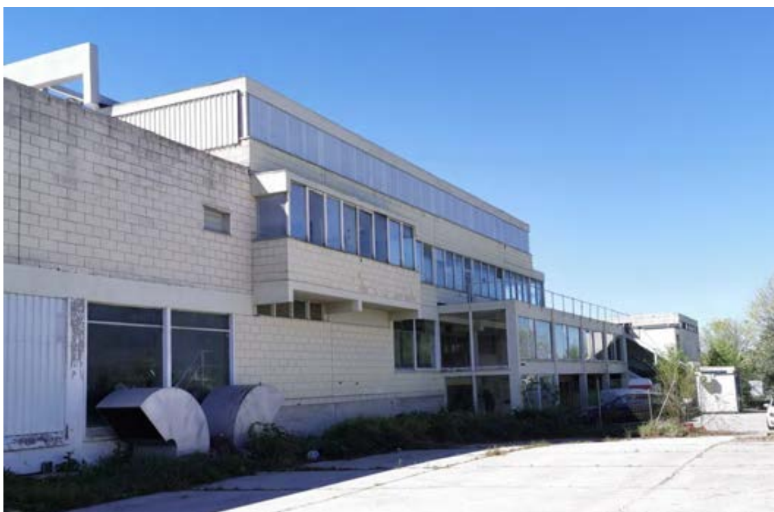
Figura 13. Estado actual de la fachada norte. Colocación de planchas onduladas traslúcidas sobre franja de carpinterías de planta segunda y opacas en ventanal planta baja (izda.). Autor. 2023/04/04.
