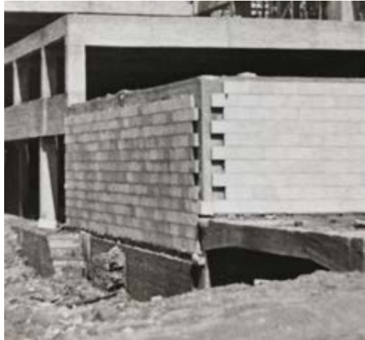
Figuras A45 y A46. Colocación de piezas prefabricadas de recubrimiento en esquinas. Fundación A. de la Sota.
