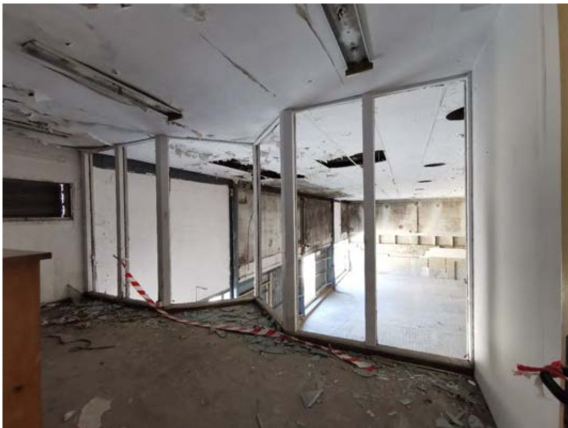
Figura A30. Mirador hacia nave de producción. Estado actual. Autor 2023/04/04.
