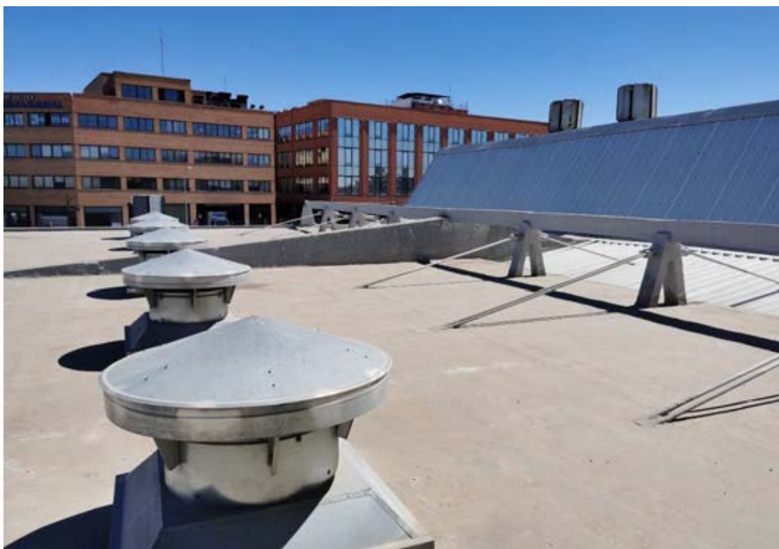
Figura 13. Cubierta de nave de producción en su zona norte con nueva impermeabilización, parte sobresaliente de la estructura y nuevo revestimiento de placas onduladas traslúcidas en lucernarios. Los extractores en primer plano no son originales. Sí en cambio los dos sobre los lucernarios.
