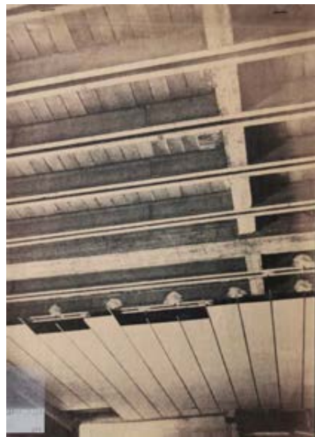
Figuras A47 y A48. Colocación de planchas Polydros de revestimiento de la estructura. Fundación A. de la Sota.
