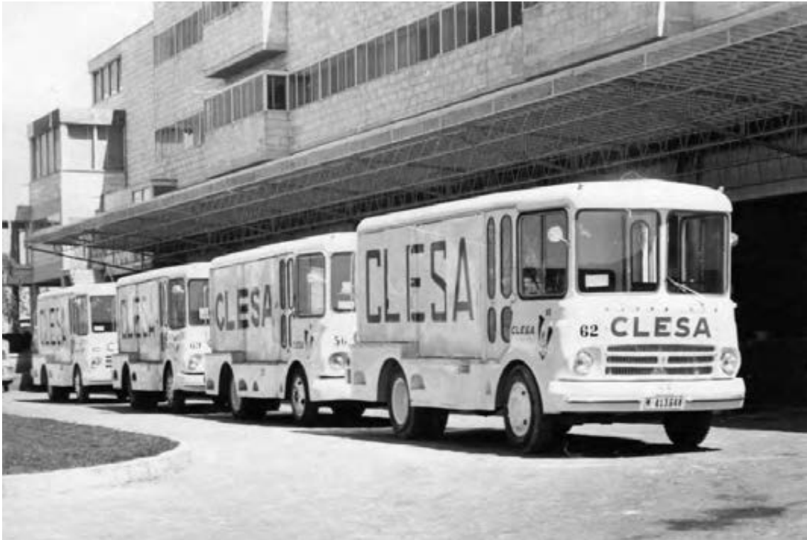
Figura A60. Vehículos de reparto bajo la marquesina metálica en muelle de carga. Posteriormente demolida por la ampliación del muelle de carga. Fundación A. de la Sota.
