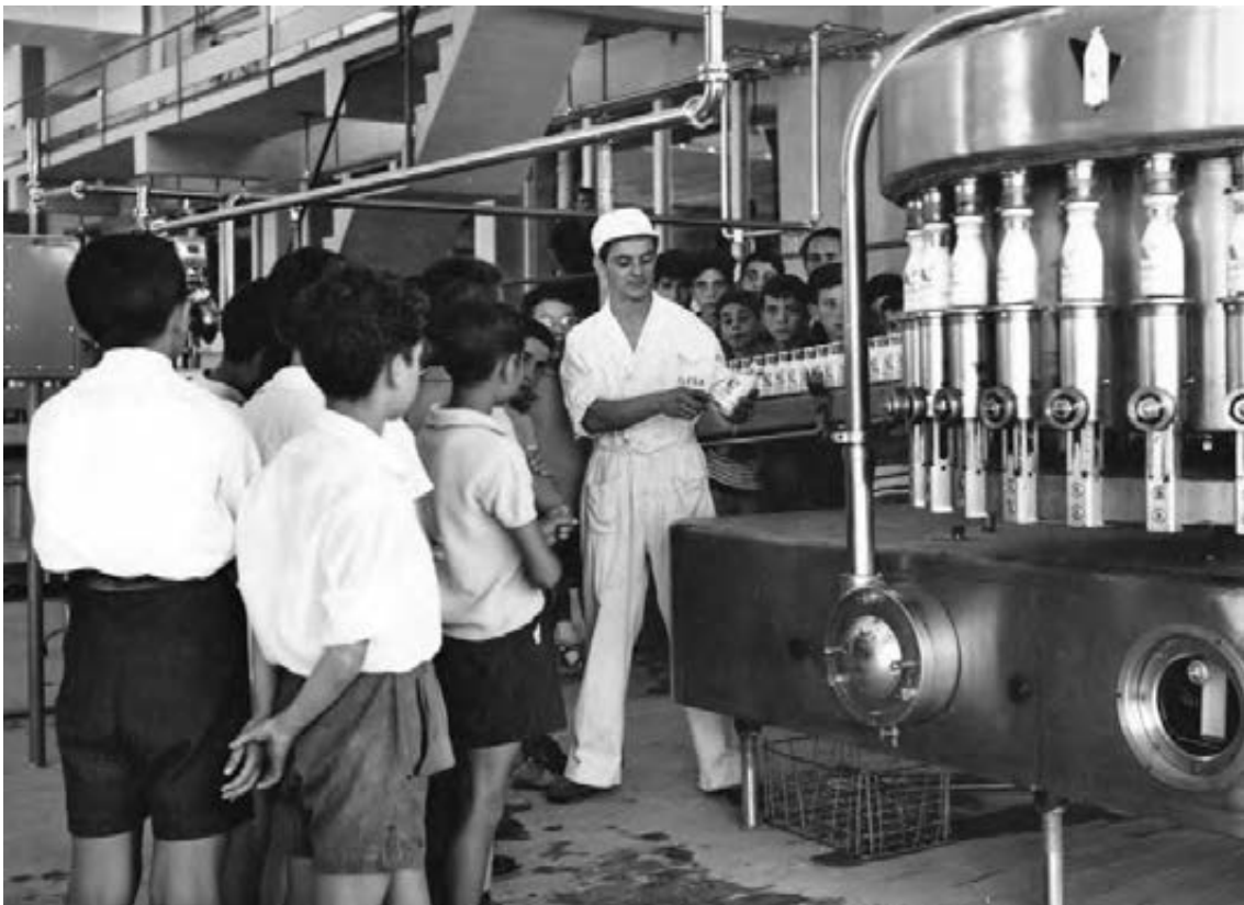
Figura A58. Visita de escolares con explicaciones del personal trabajador. Fundación A. de la Sota.
