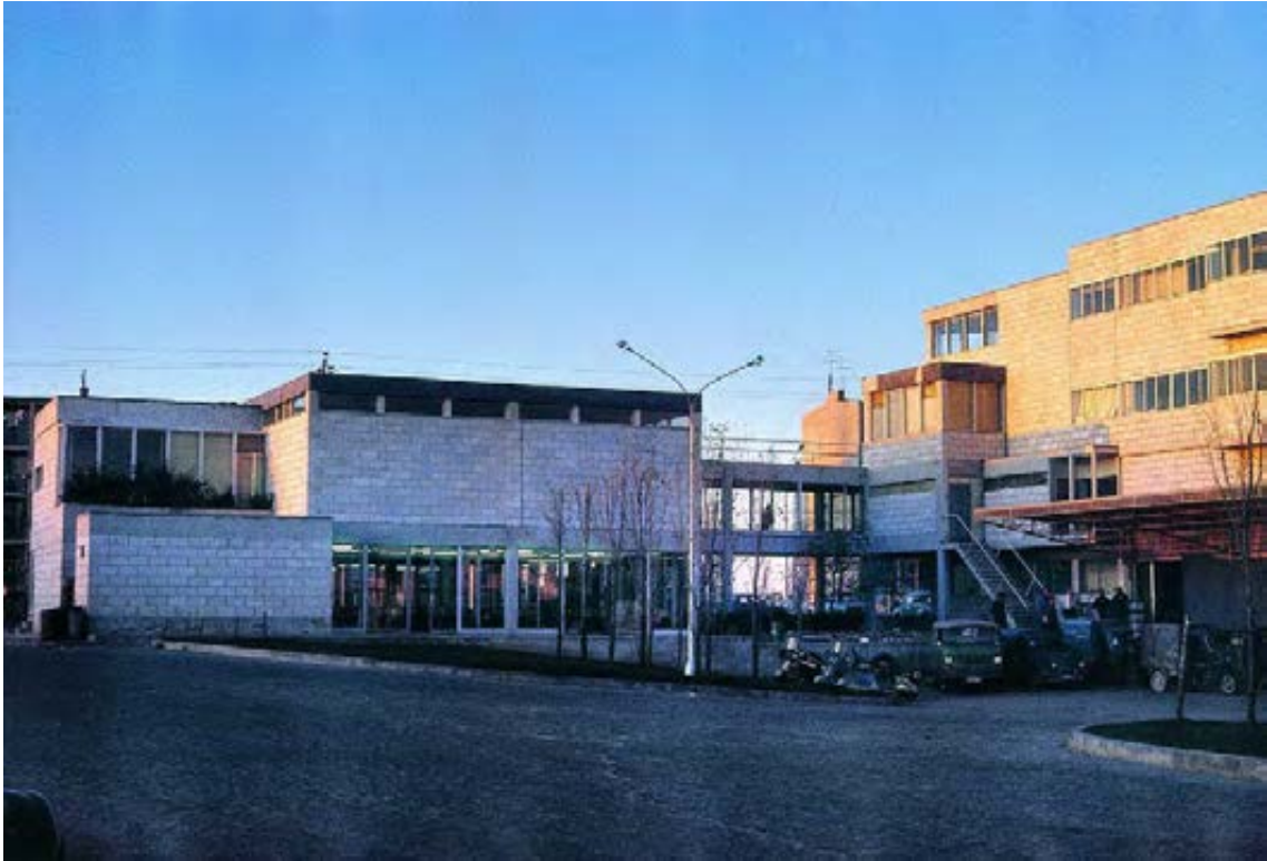
Figura A42. Zona de vestuarios con puente transparente acristalado de conexión. Fundación A de la Sota.
