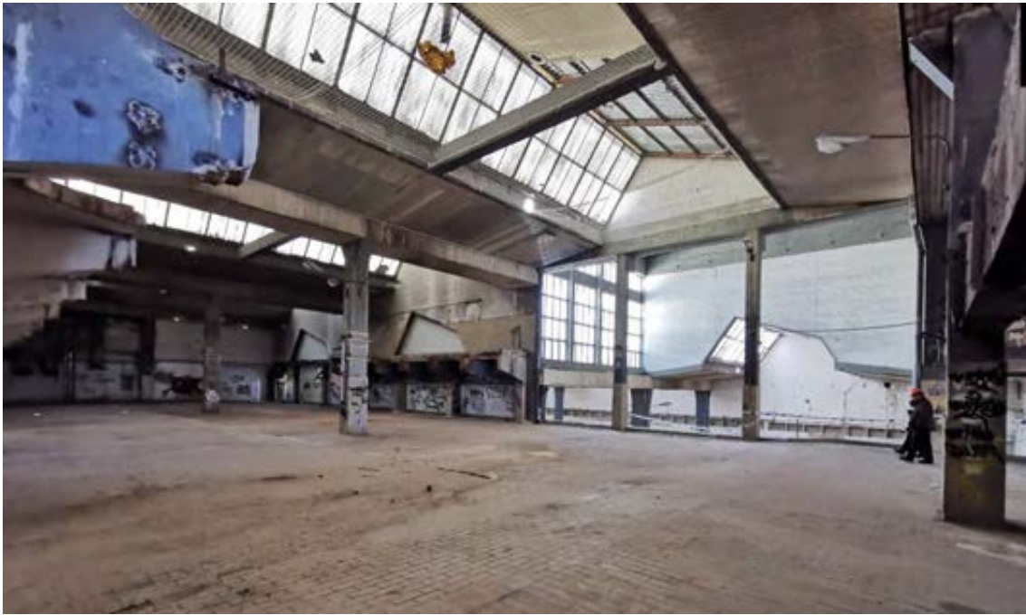
Figura 13. Interior desde nave de tratamientos. Imagen de estado general de interiores. Autor. 2023/04/04.
