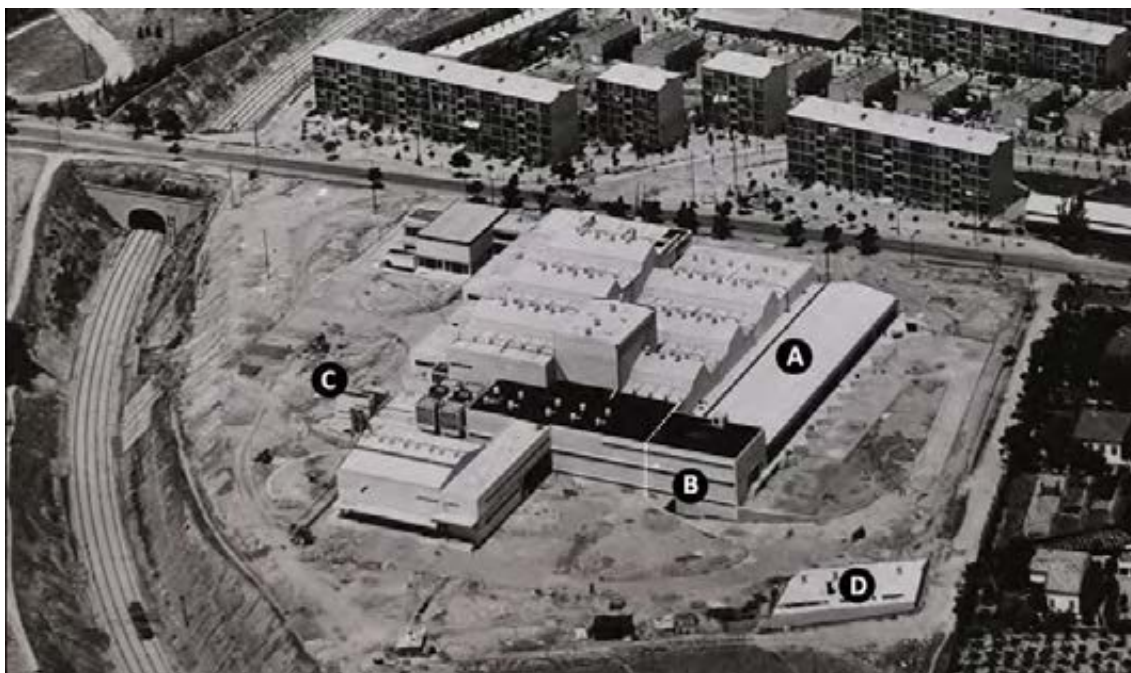
Figura 9. Partes originales demolidas. Foto Fundación Alejandro De de la Sota.
