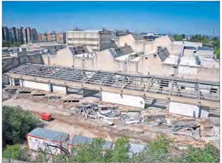
Demolición de los edificios sin proteger de la antigua fábrica Clesa en Madrid, en julio. / NIMA FLORES
