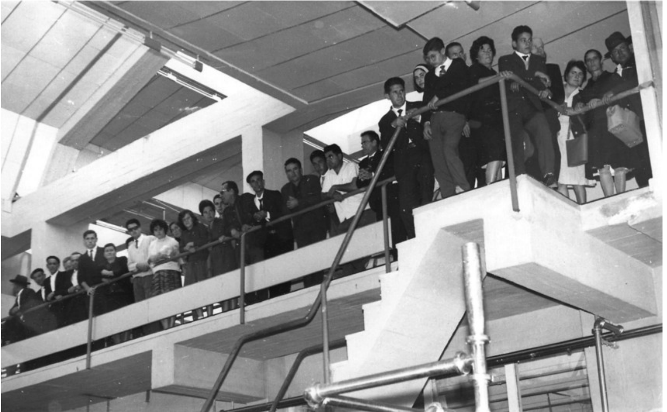
Relación de la fábrica con la ciudadanía. Fotografía del interior de la fábrica CLESA que muestra la pasarela de acceso público para las visitas organizadas desde la que se recorría toda la fábrica y se entendía el proceso productivo. Archivo digital Fundación Alejandro de la Sota.
