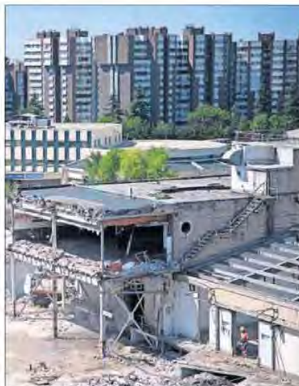
Obras de reforma de la nave de Clesa el 30 de julio. / IMAA FLORES
