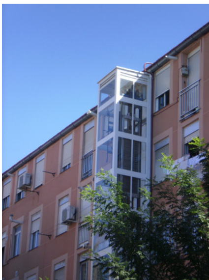
Aislamiento de fachadas y ascensor exterior en la colonia Erillas (barrio de San Diego, Puente de Vallecas)
