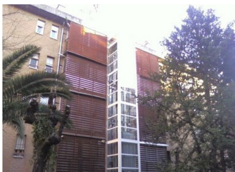
Ascensor exterior en la ZRI de Entrevías, c/ La Mancha
