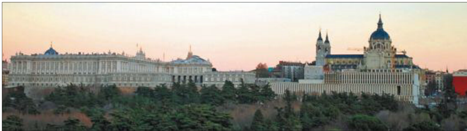
Impacto paisajístico de la nueva construcción sobre la fachada de la Catedral de la Almudena. /CARLOS ROSILLO
