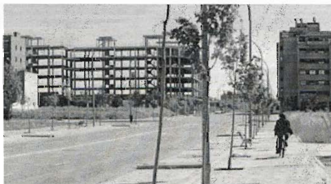
Pisos en ejecución frente a otros habitados en una avenida del Ensanche de Vallecas. S. CHERKAOU
